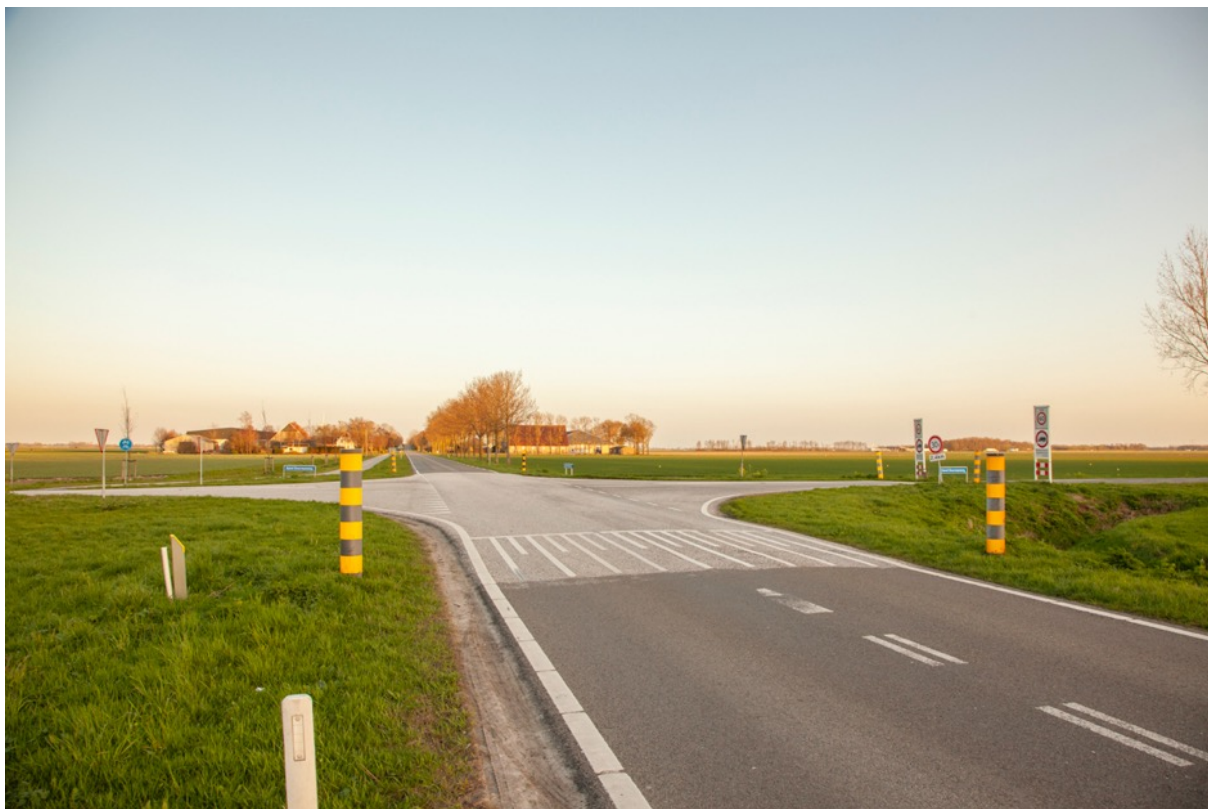
Foto: Zuidwesterringweg waar op kruisingsvlak lichter kleur wegdek materiaal is toegepast.
