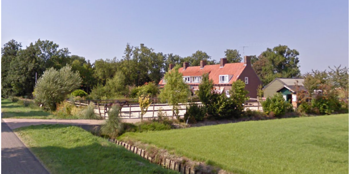
Foto: Paardenbak in Rutten. Geen verlichting geplaatst en dus in de avond niet van verre zichtbaar.
