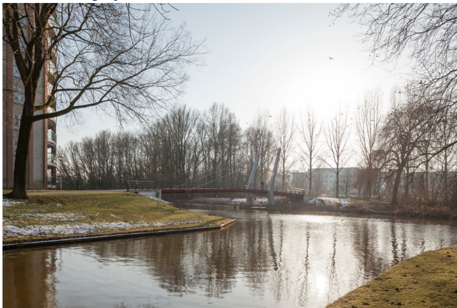
Foto: fietsbrug in Emmeloord, doorgaande fietsroute binnen de kom is verlicht.
