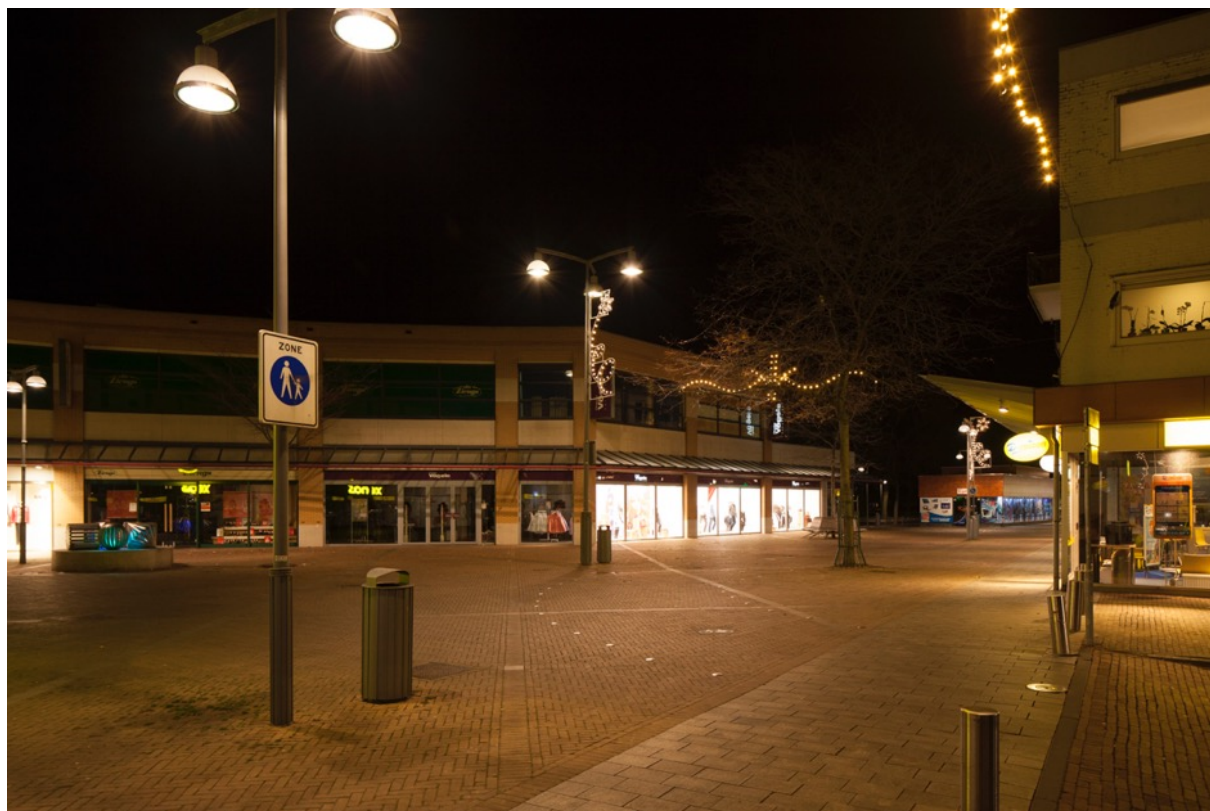
Foto: Centrum in Emmeloord, verlichte etalage waardoor de openbare verlichting wegvalt en het donker op straat lijkt.
